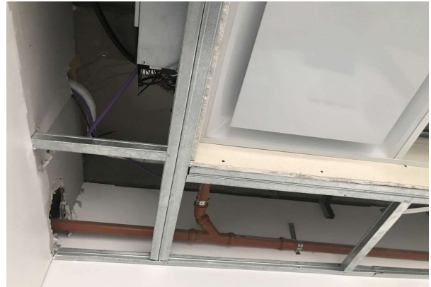
DESAGUES DE EQUIPOS DE AIRE ACONDICIONADO A BANO EXISTENTE
