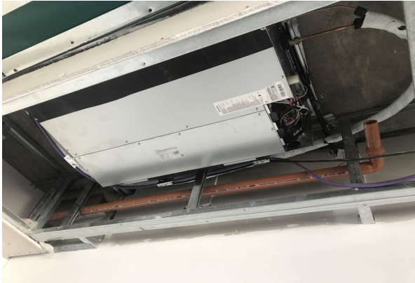
DESAGUES DE EQUIPOS DE AIRE ACONDICIONADO A BANO EXISTENTE
