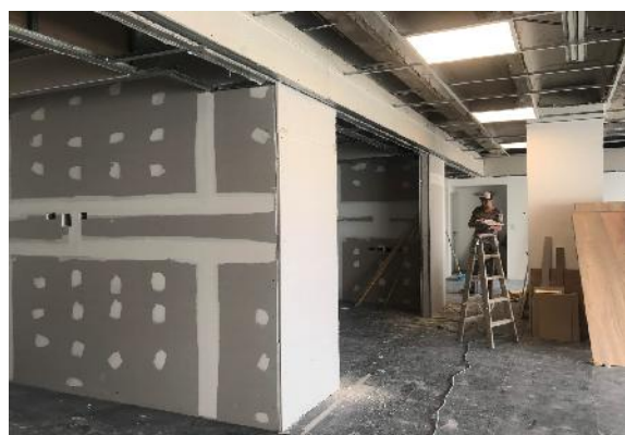
EMPLAQUE DE TABIQUES + CAÑERÍAS PARA ALIMENTADOR DE RACK
