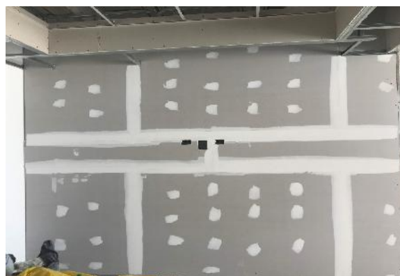
EMPLAQUE DE TABIQUES + CAÑERÍAS PARA ALIMENTADOR DE RACK
