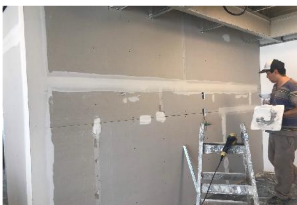
EMPLAQUE DE TABIQUES + CAÑERÍAS PARA ALIMENTADOR DE RACK
