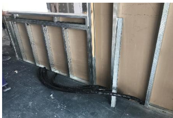
EMPLAQUE DE TABIQUES + CAÑERÍAS PARA ALIMENTADOR DE RACK
