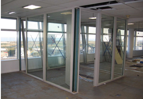
COLOCACIÓN DE VIDRIOS LAMINADOS EN TABIQUERIA MODULAR
