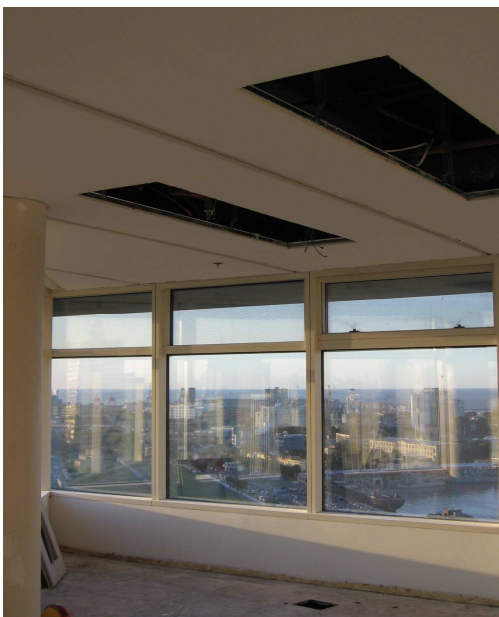
ENDUÍDO Y PINTURA EN TABIQUES Y CIELORRASOS DE COFFEES
