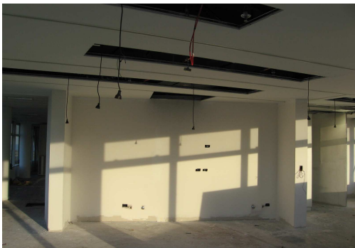
ENDUÍDO Y PINTURA EN TABIQUES Y CIELORRASOS DE COFFEES
