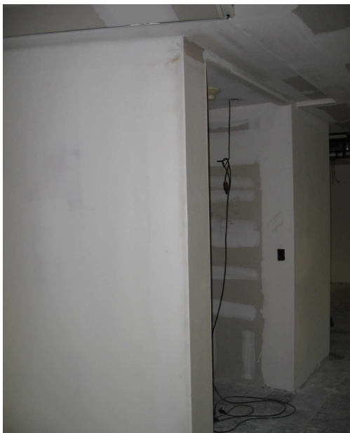
TABIQUE Y CIELORRASOS EN HALL DE ASCENSORES VIP
