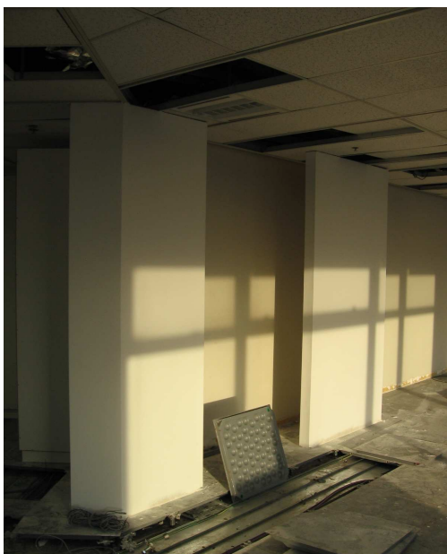
GABINETES PARA RACKS DE CABLEADO DE PISO
