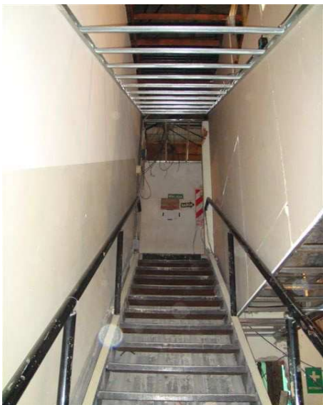
CIERRE CAJA DE ESCALERAS INGRESO A SECTOR ENTREPISO.
