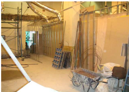
EJECUCION DE NUEVOS TABIQUES DIVISORIOS. EMPLACADO PRIMERA CARA.
