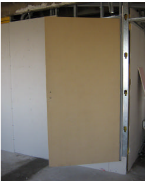
EMPLACADO EXTERIOR, TENDIDO DE CAÑERÍAS DE AIRE ACONDICIONADO Y COLOCACION DE PUERTA EN NUEVO DATA CENTER
