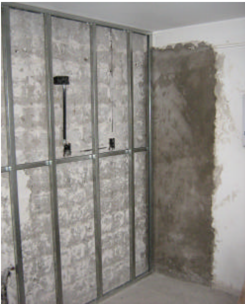
REPARACIÓN DE REVOQUES EN COFFEE BREAK
