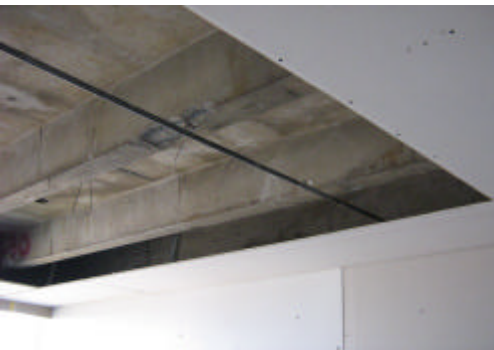
EJECUCIÓN DE AJUSTES PERIMETRALES EN CIELORRASOS DE DESPACHOS PRIVADOS
