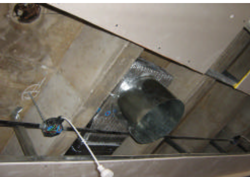
COLOCACIÓN DE COLLARES EN CONDUCTOS DE INYECCIÓN DE AIRE ACONDICIONADO
