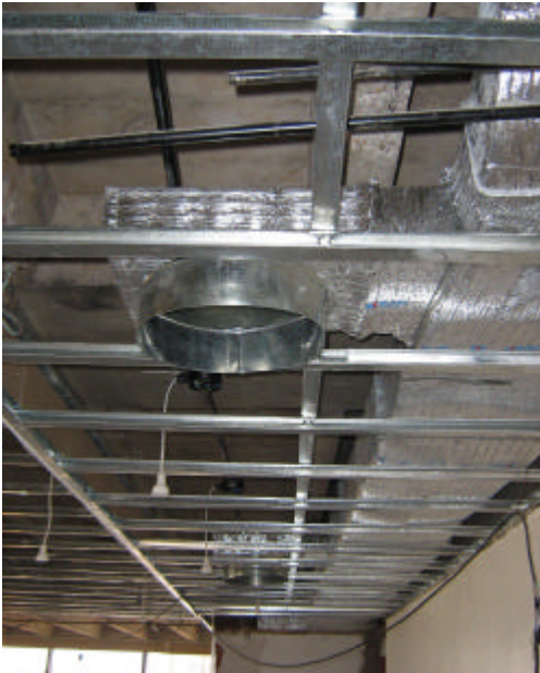
COLOCACIÓN DE COLLARES EN CONDUCTOS DE INYECCIÓN DE AIRE ACONDICIONADO
