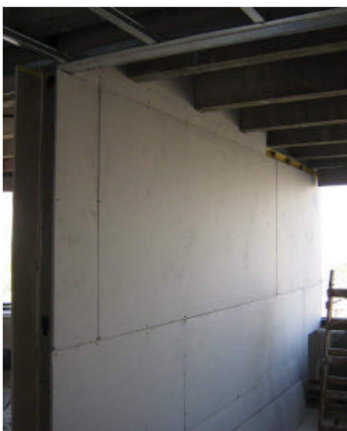
EMPLACADO DE SEGUNDA CARA DE NUEVOS TABIQUES DIVISORIOS
