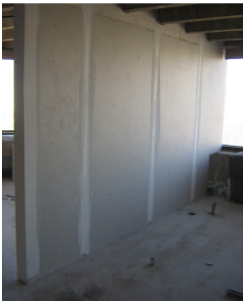
ENCINTADO Y MASILLADO DE JUNTAS DE NUEVOS TABIQUES DIVISORIOS
