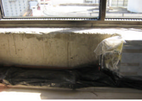
PROTECCIÓN PROVISORIA DE CAÑERÍAS DE AGUA EN FANCOILS PERIMETRALES
