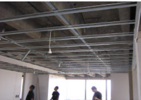
EJECUCIÓN DE ESTRUCTURA DE CIELORRASOS EN CIRCULACIONES
