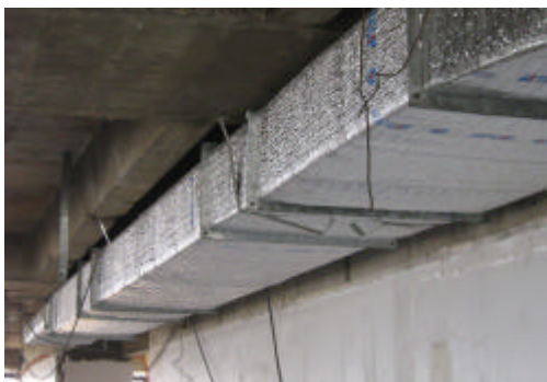
INSTALACIÓN DE NUEVOS CONDUCTOS DE INYECCIÓN DE AIRE ACONDICIONADO AISLADOS
