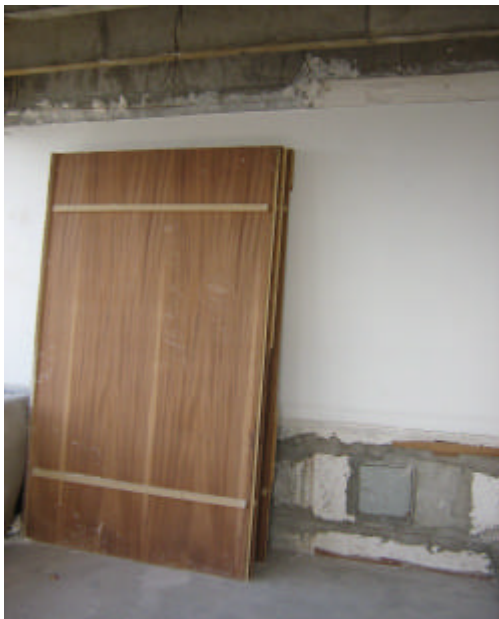
DESMONTAJE DE REVESTIMIENTOS DE MADERA EXISTENTES
