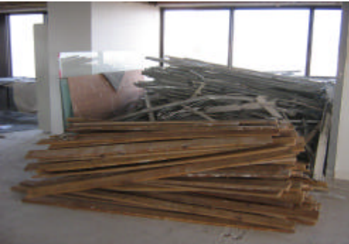
BAJADA DE ESCOMBROS A VOLQUETES Y LIMPIEZA DE OBRA
