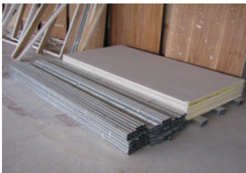
ACOPIO DE MATERIALES PARA EJECUCIÓN DE NUEVOS TABIQUES Y CIELORRASOS
