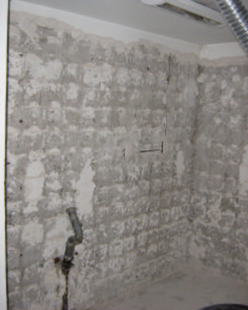
DESMONTAJE DE REVESTIMIENTOS, MUEBLES Y MESADAS DE COCINA
