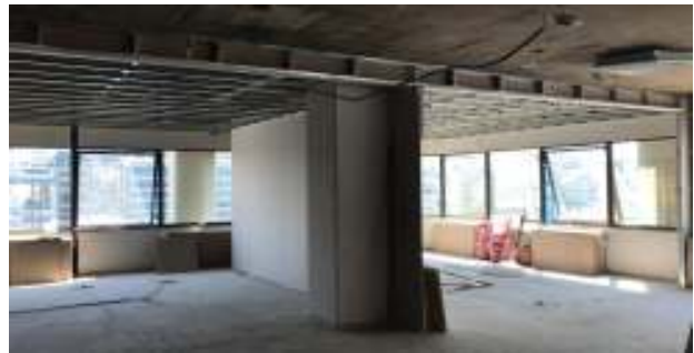
TABIQUE DE ROCA DE YESO - ESTRUCTURA Y 1 PLACA
