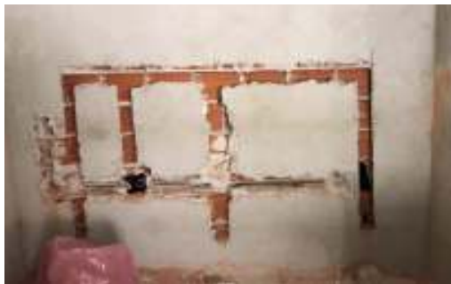
DESMONTE DE VALVULAS DE INODOROS EXISTENTES - REVOQUES NUEVOS EN BAÑOS
