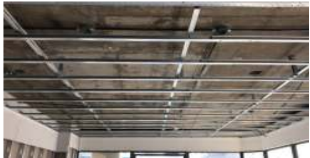
CIELORRASO DE ROCA DE YESO - ESTRUCTURA
