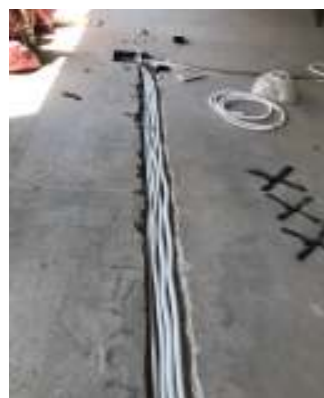
CANALIZACIONES EN PISO Y TABIQUES DE ROCA DE YESO - REFUERZOS DE MADERA
