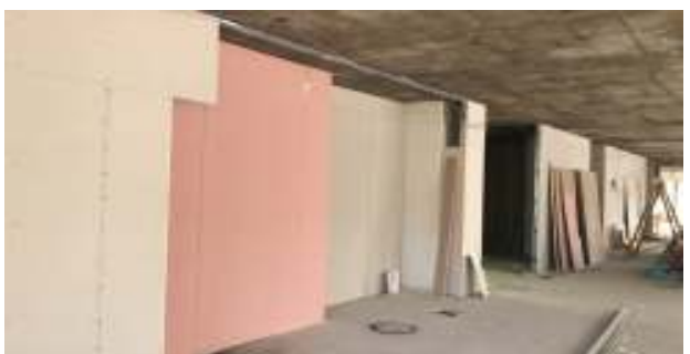
TABIQUE DE ROCA DE YESO - ESTRUCTURA + AISLACION
