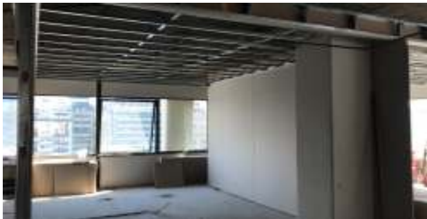
CIELORRASO DE ROCA DE YESO - ESTRUCTURA
