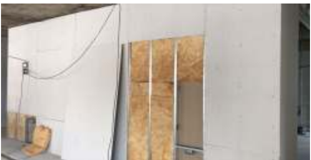
TABIQUE DE ROCA DE YESO - ESTRUCTURA + AISLACION
