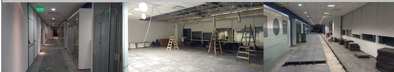
Sector pasillo c/piso técnico nuevo colocado
