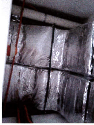
14. Terminación cielo raso.
