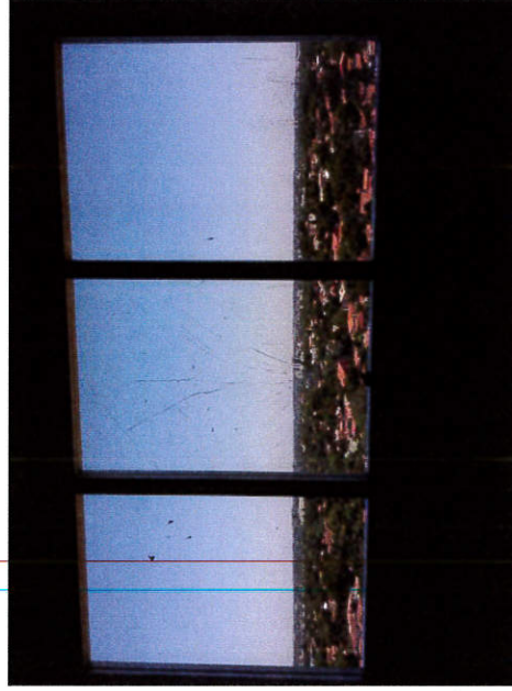
21. Vidrio roto en Hoja móvil de ventana. Restos de mezcla en el exterior.
