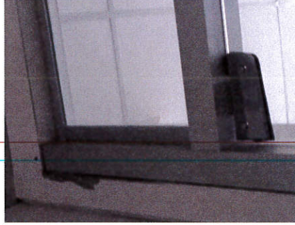
13. Terminación de vidrio fijo sobre puerta de acceso a unidad.
