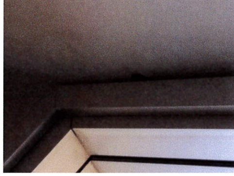
22. Terminación pilar / ventana. Hueco.
