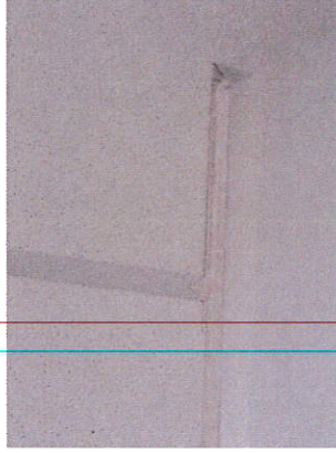
11. Terminación de pintura en mampara / perfil metálico de cielo raso.
