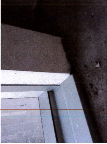
27. Terminación zócalo / perfil metálico en ochava.
