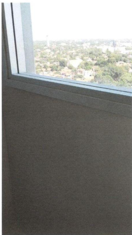
23. Manchas en pared bajo carpintería de aluminio
