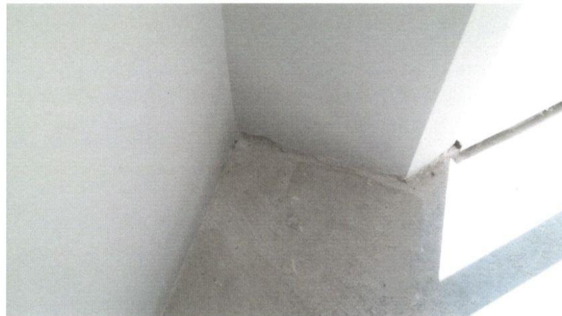
22. Terminacion de Carpeta
