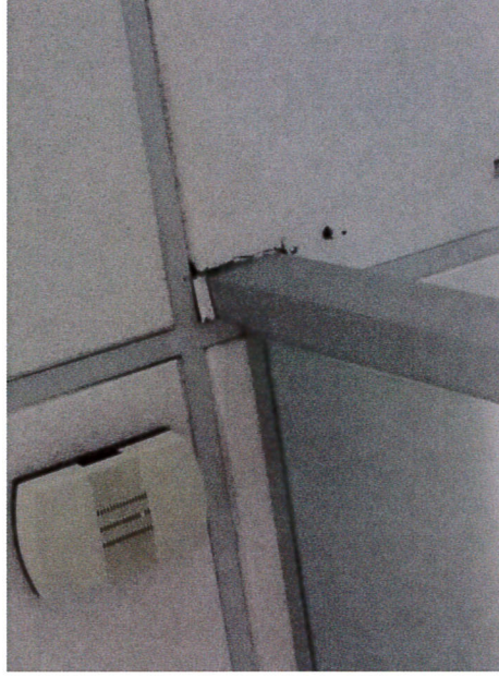
11. Terminación de placa de Cielo raso dañada en unión con mampara de vidrio.
