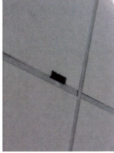
11. Terminación de placa de Cielo raso dañada en unión con mampara de vidrio.
