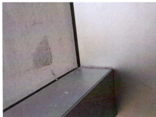
26. Terminación de Silicona en ochava.
