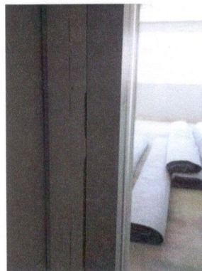
14. Terminación de perfil de puerta de acceso / tabique de yeso. ✓
