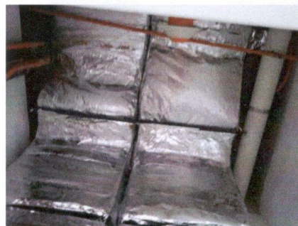
14. Terminación cielo raso.
