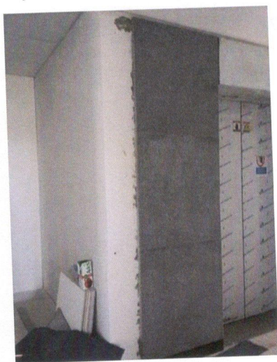
09. Terminación muro de ascensor, perforación, restos de revoque grueso. ✓
