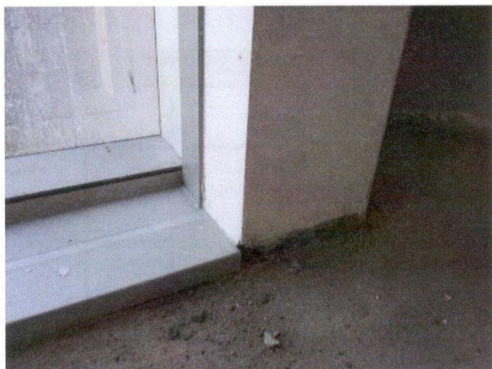
27. Terminación zócalo / perfil metálico en ochava.
