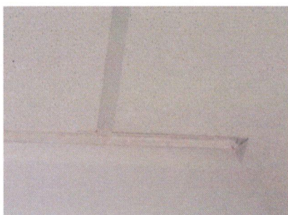
11. Terminación de pintura en mampara / perfil metálico de cielo raso.
