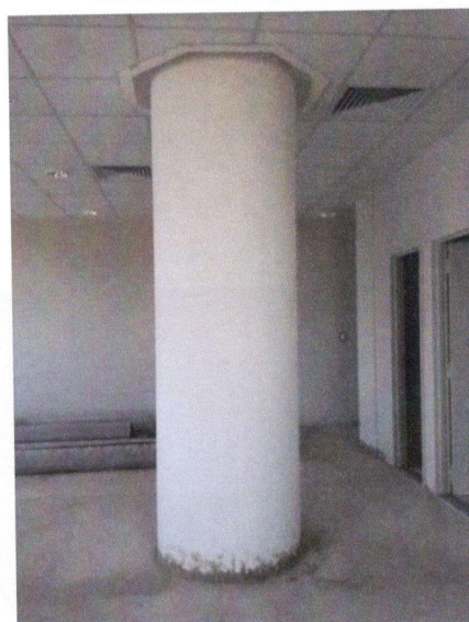
18. Terminación de columna.
