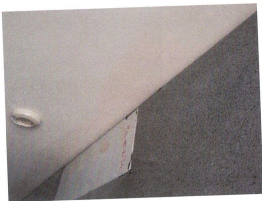
05. Terminación de pintura en cielo raso. ✓
