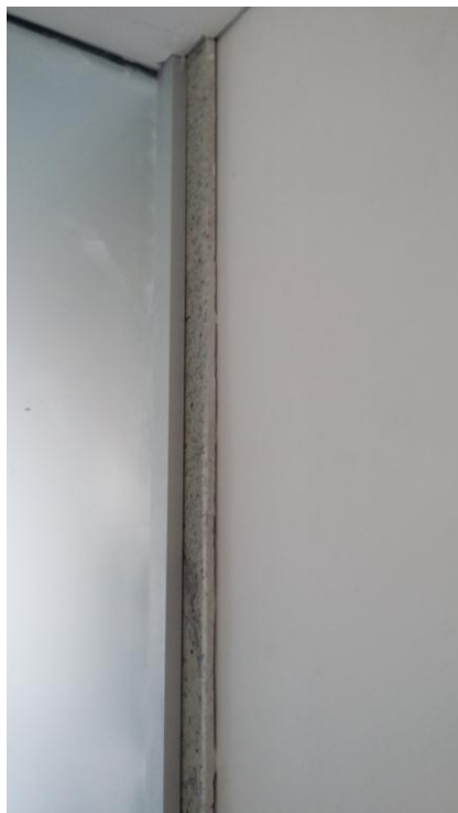
22. Terminacion siliconado en uniones
