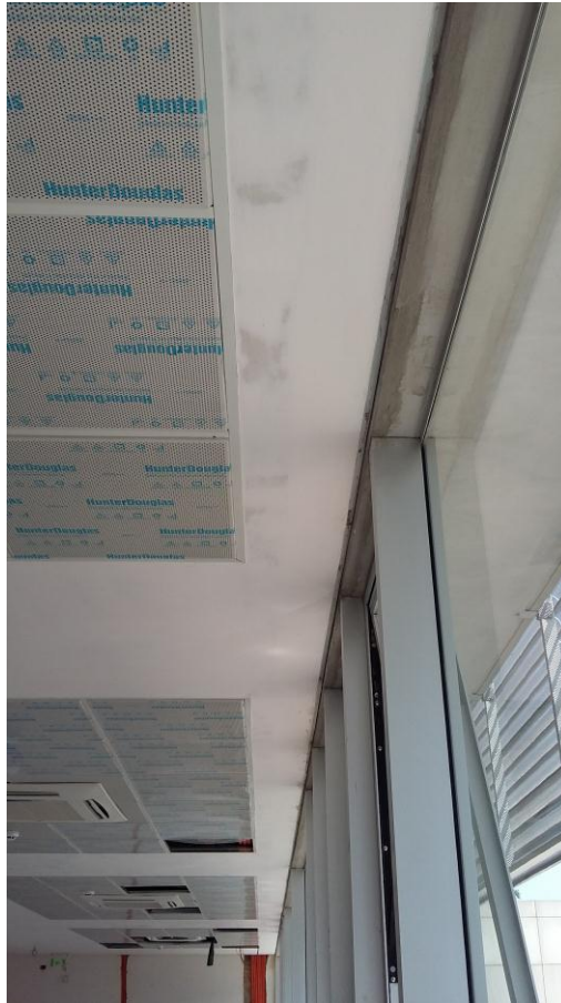
29. Terminacion cieloraso y mocheta
