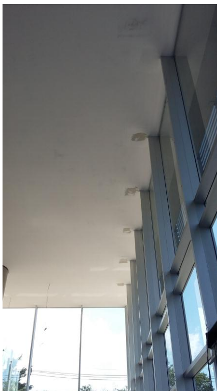
15. Terminaciones de cielorrasos
