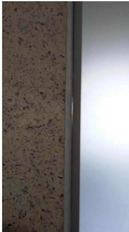
20. Terminacion siliconado en uniones
