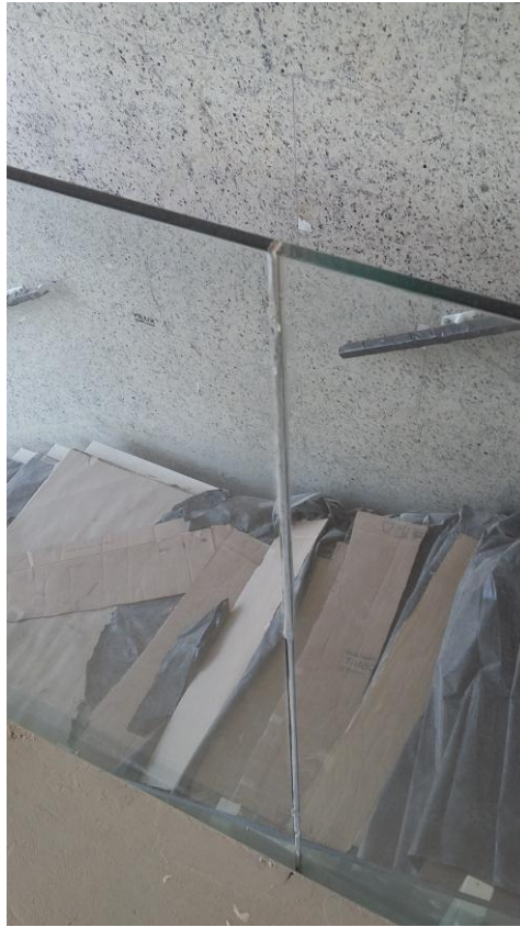
18. Baranda de cristal templado, terminaciones y siliconado
