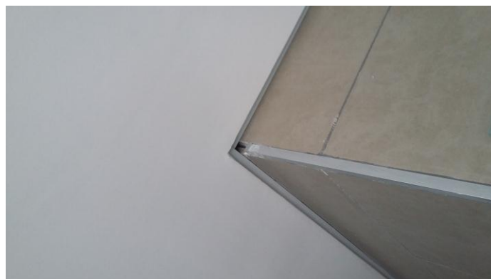
32. Terminacion de cantonera
