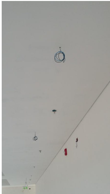
26. Instalacion eléctrica e iluminacion
