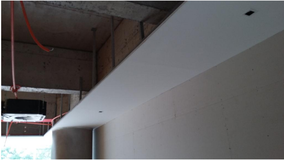
4. Cielorraso se marca la Estructura / Terminacion Pilar
