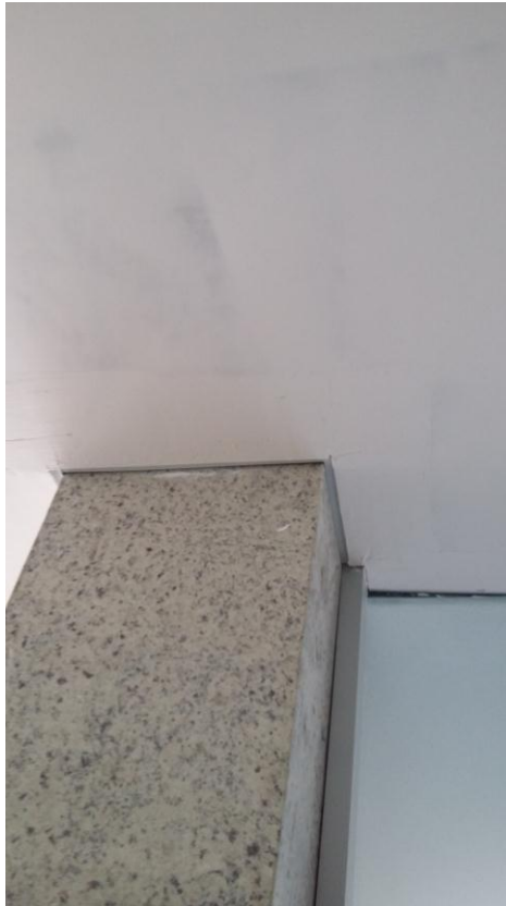
19. Terminacion de cielorraso
