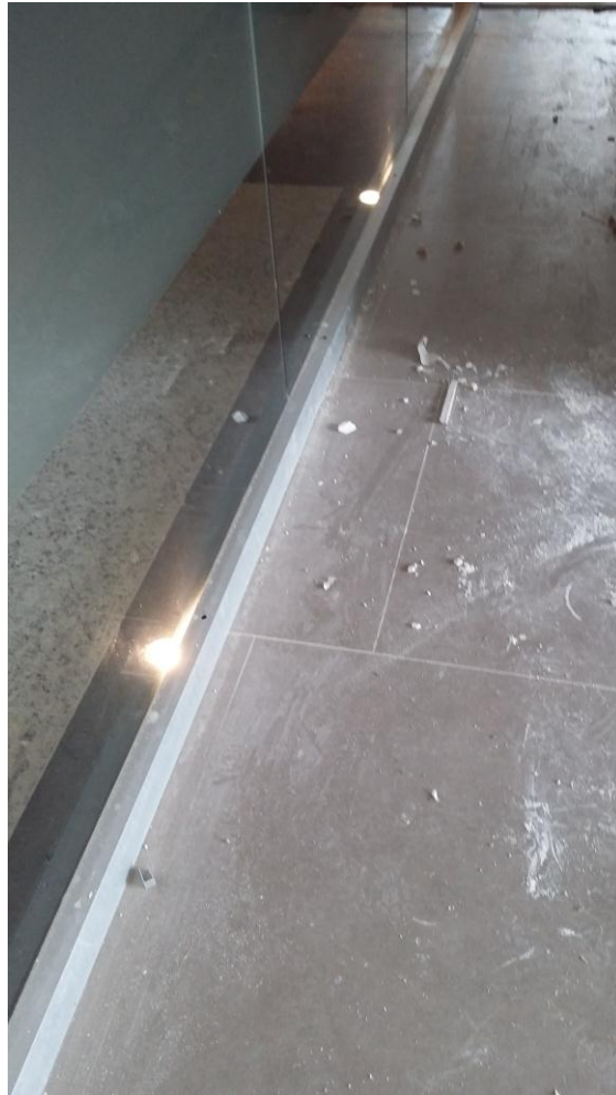
02. Terminacion en perfileria
