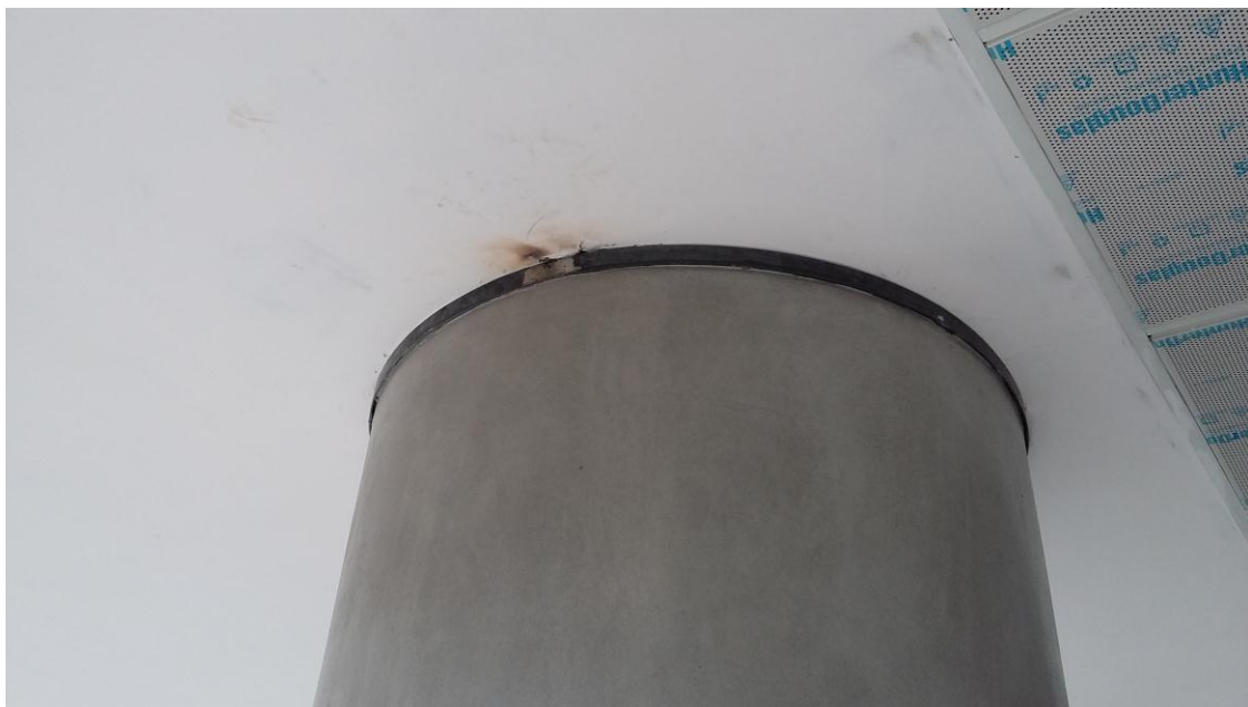
5. Terminacion en Pilar
