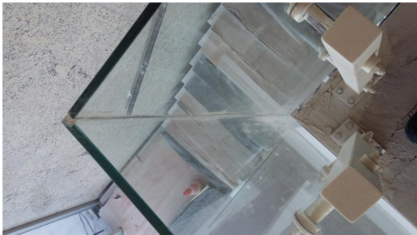
18.1 Baranda de cristal templado, terminaciones y siliconado
