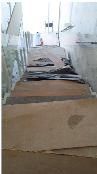
17. Escalera con protección de carton y aislapol
