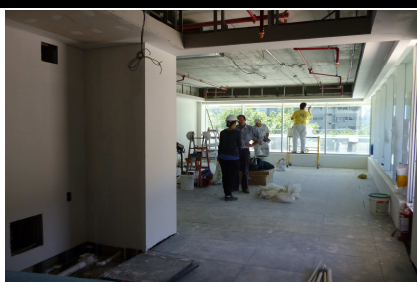
Vista general: Colocación de equipos de aire, tabiquería, cielorraso de yeso, tomas de eléctrica, instalación sobre cielorraso
