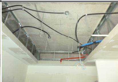
Instalación eléctrica sobre cielorraso de sala de reuniones
