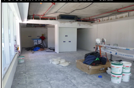
Vista general: Colocación de equipos de aire, tabiquería, cielorraso de yeso, tomas de eléctrica, instalación sobre cielorraso
