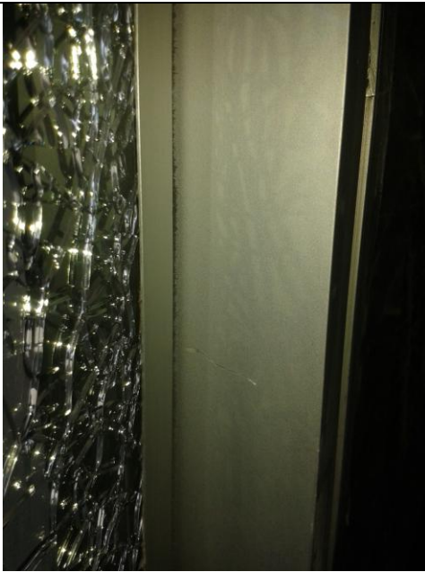
Puerta acceso a terraza
