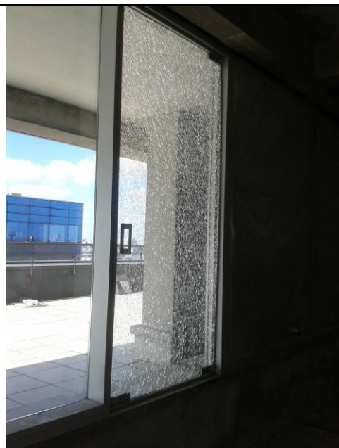
Puerta acceso a terraza
