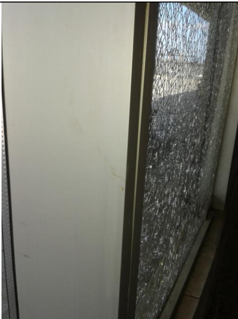
Puerta acceso a terraza
