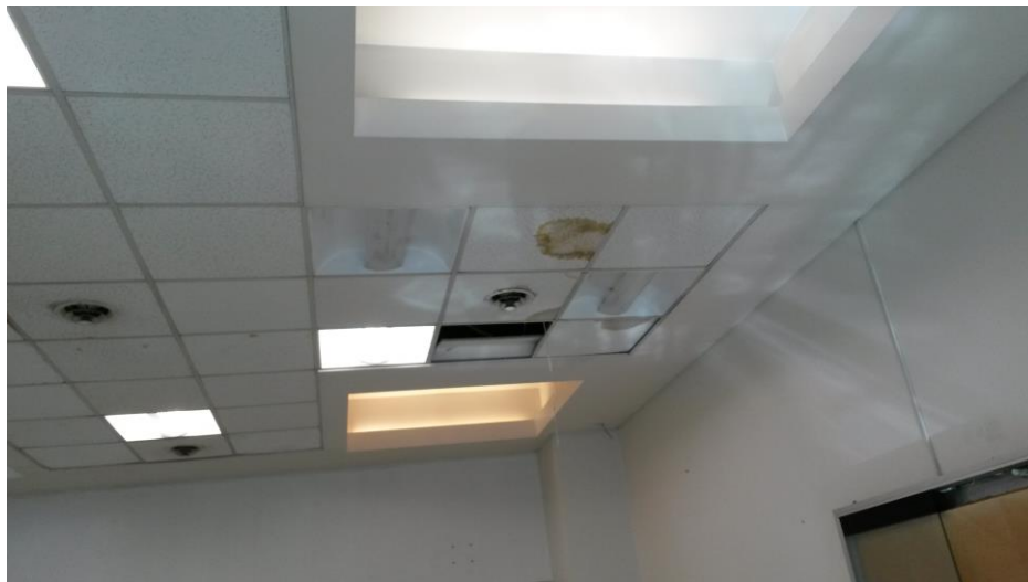
Foto 23 a-b-c-d Cielorraso del comedor – Placas en mal estado, placas manchadas, estructura dañada, artefactos en cajones de durlock que no funcionan - Tarea de reparación no contemplada en el presupuesto.
