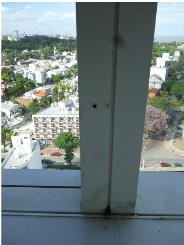
Aberturas de aluminio con perforaciones.
