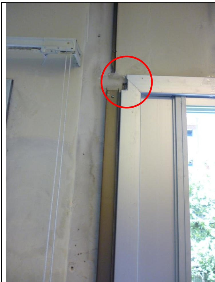
ABERTURA DE FACHADA
