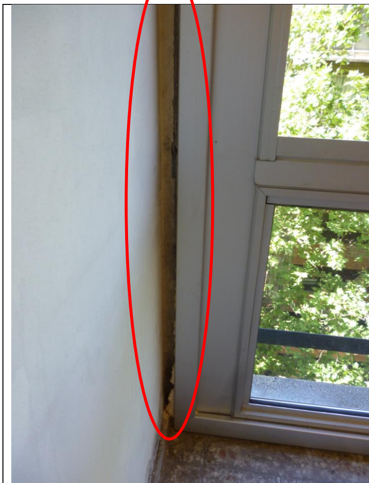
ABERTURA DE FACHADA
