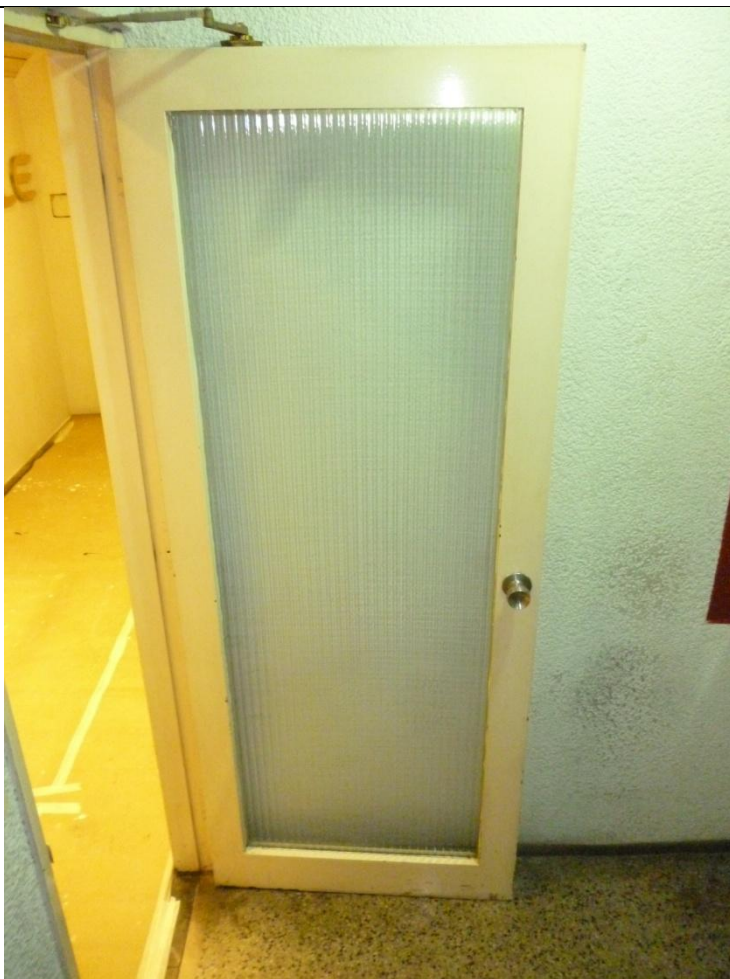
PUERTA HALL DE ESCALERA
