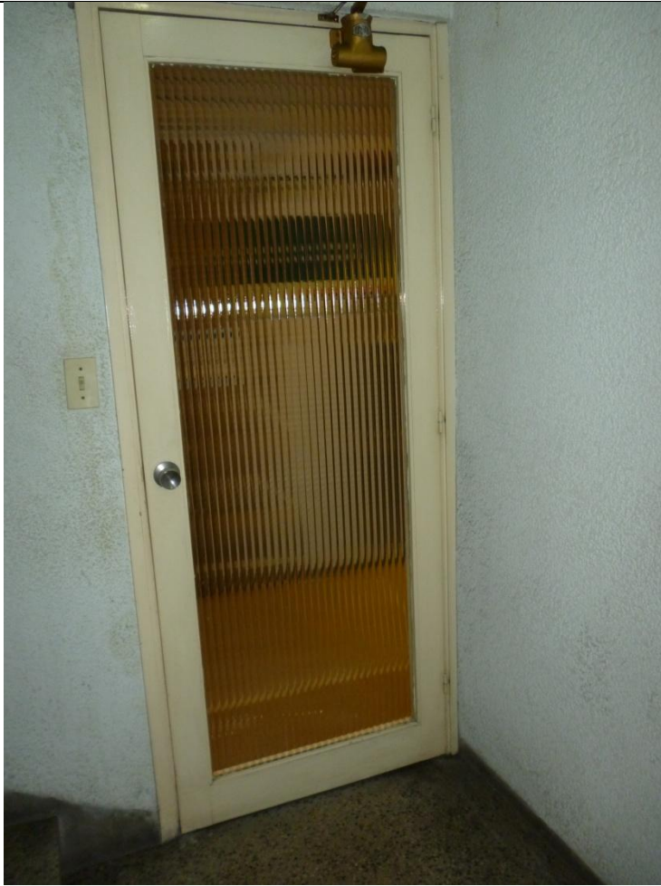
PUERTA HALL DE ESCALERA
