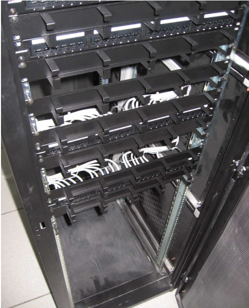
IMPACTADO DE CABLEADO ESTRUCTURADO EN PATCH PANNELS DE NUEVO DATA CENTER.
