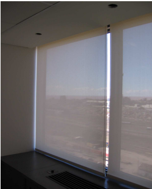
INSTALACION DE CORTINAS ROLLER.
