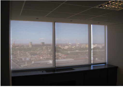
INSTALACION DE CORTINAS ROLLER.
