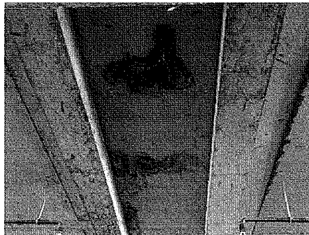
Fotos 1, 2 y 3: goteras en diversos puntos de la losa y vigas
