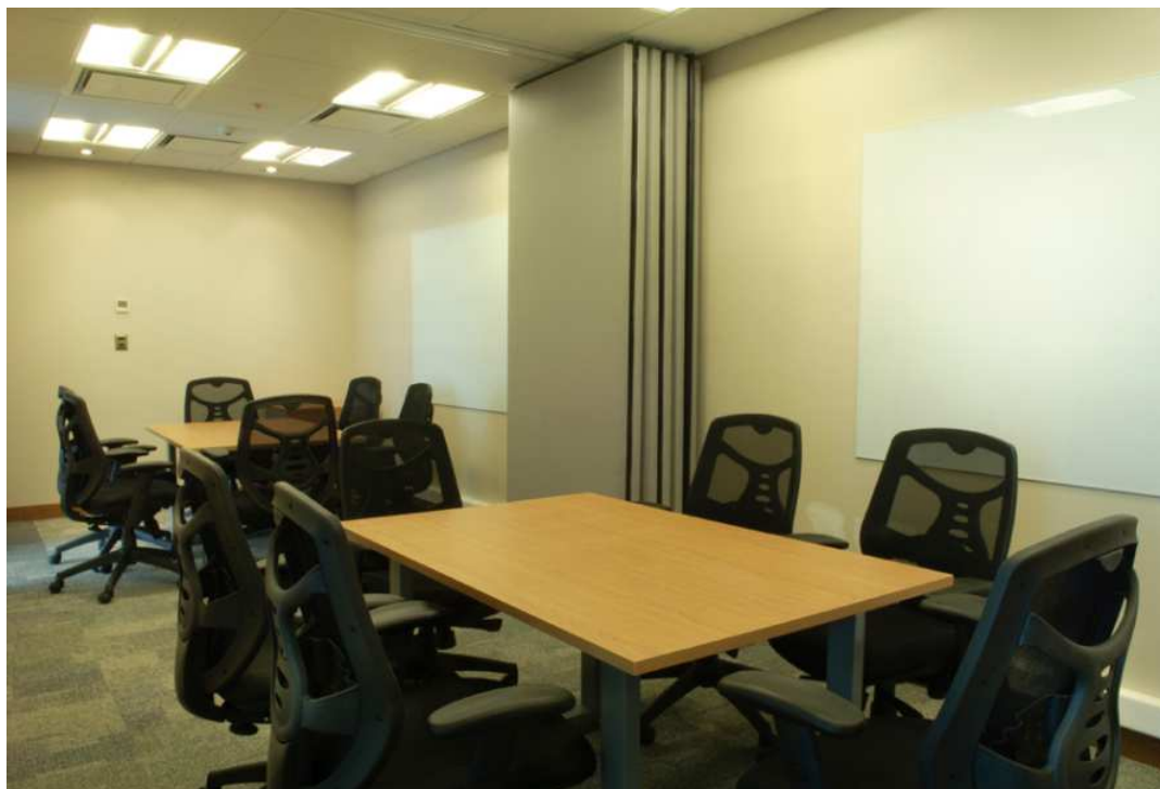
Tabique móvil en sala de reuniones. Terminación vinílica
