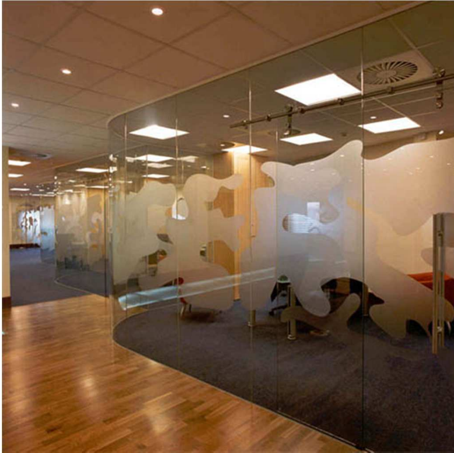
CRISTAL LAMINADO 4+4 PERFILERÍA DE ALUMINIO EN BORDES INFERIOR Y SUPERIOR
