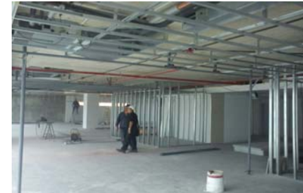
Montaje Estruct. Metal. Cielorraso 9° Sala de Reunion
