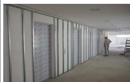
Montaje Estruct. Metal. p/soporte Revestimiento Vidrio 7° al 10° Hall Ascensores
