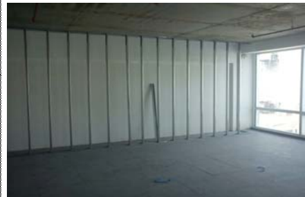
Inicio Montaje Estruct. Metalica Rectificacion Medianera Sur 3° Oficinas
