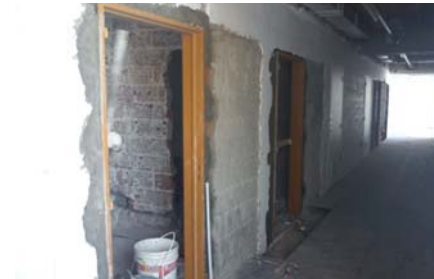
Sanitarios 5° (Colocacion de Marcos), 6° al 10° modificacion según v11-03
