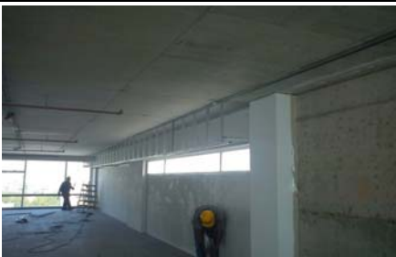
Montaje Estruct. Metal. Cajon Cierre Superior Mueble Guardado - Archivo 9° Oficinas
