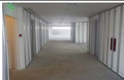
Montaje Estruct. Metal. p/soporte Revestimiento Vidrio 10° Hall Ascensores
