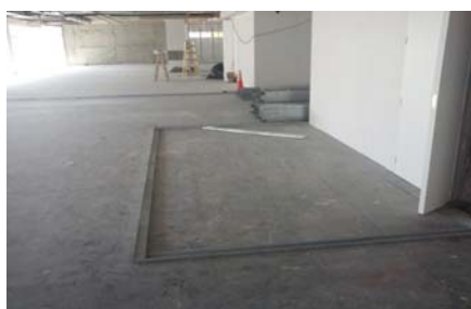
Inicio Montaje Estruct. Metalica Obra Seca 3° Office/Guardarropa
