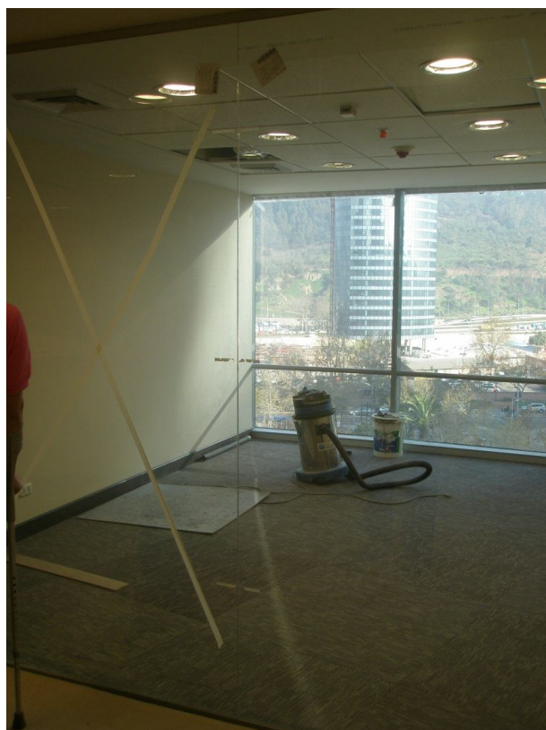
Foto 5_Oficinas. Comenzaron la limpieza por oficina. Se irá colocando film en los vidrios.
