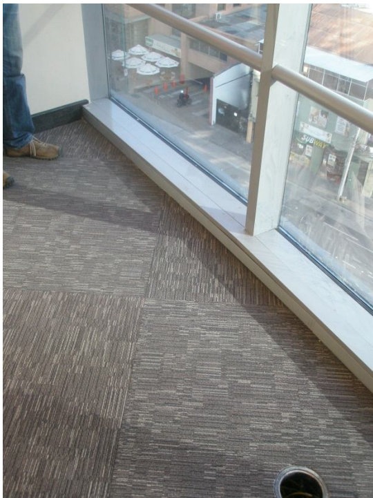
Fotos 3 y 4_oficinas. Se están colocando chapas de terminación de perfiles de ventana. Faltan ajustes de guardapolvos
