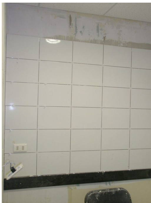
Foto 2_Kitchenette. Se colocaron cerámicos de revestimiento pared sobre la mesada
