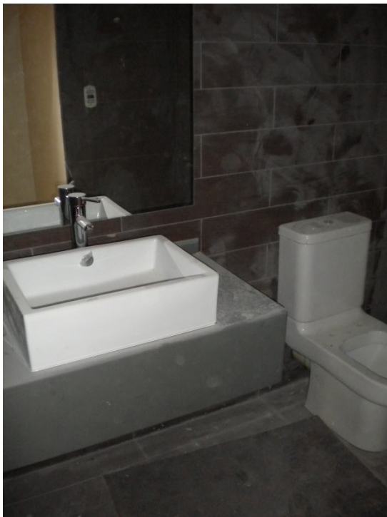
Fotos 3 y 4_baños. Se colocaron artefactos, y se colocó un perfil rehundido de remate de los cerámicos.
