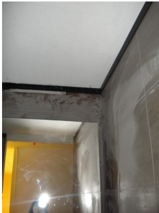
Fotos 3 y 4_baños. Se colocaron artefactos, y se colocó un perfil rehundido de remate de los cerámicos.
