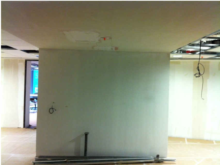
FOTO 1 – VISTA TABIQUE ACCESO
