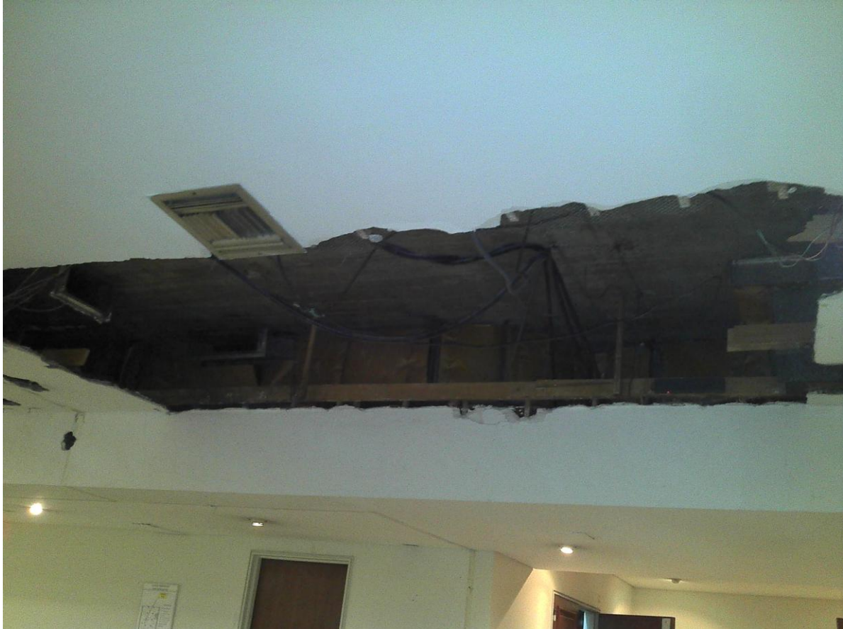
Hueco para la prueba de Proyecciones
