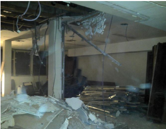
Demolición de Cielorrasos
