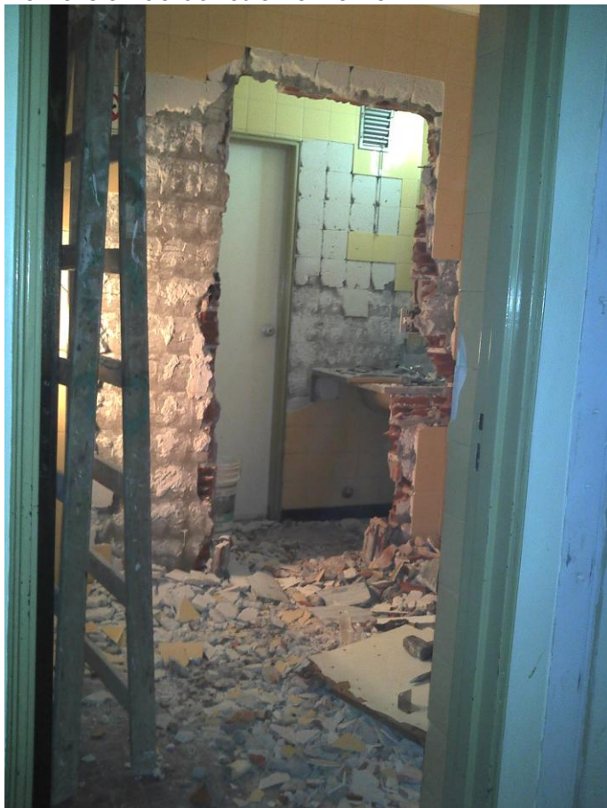
Demolición de baños en el frente
