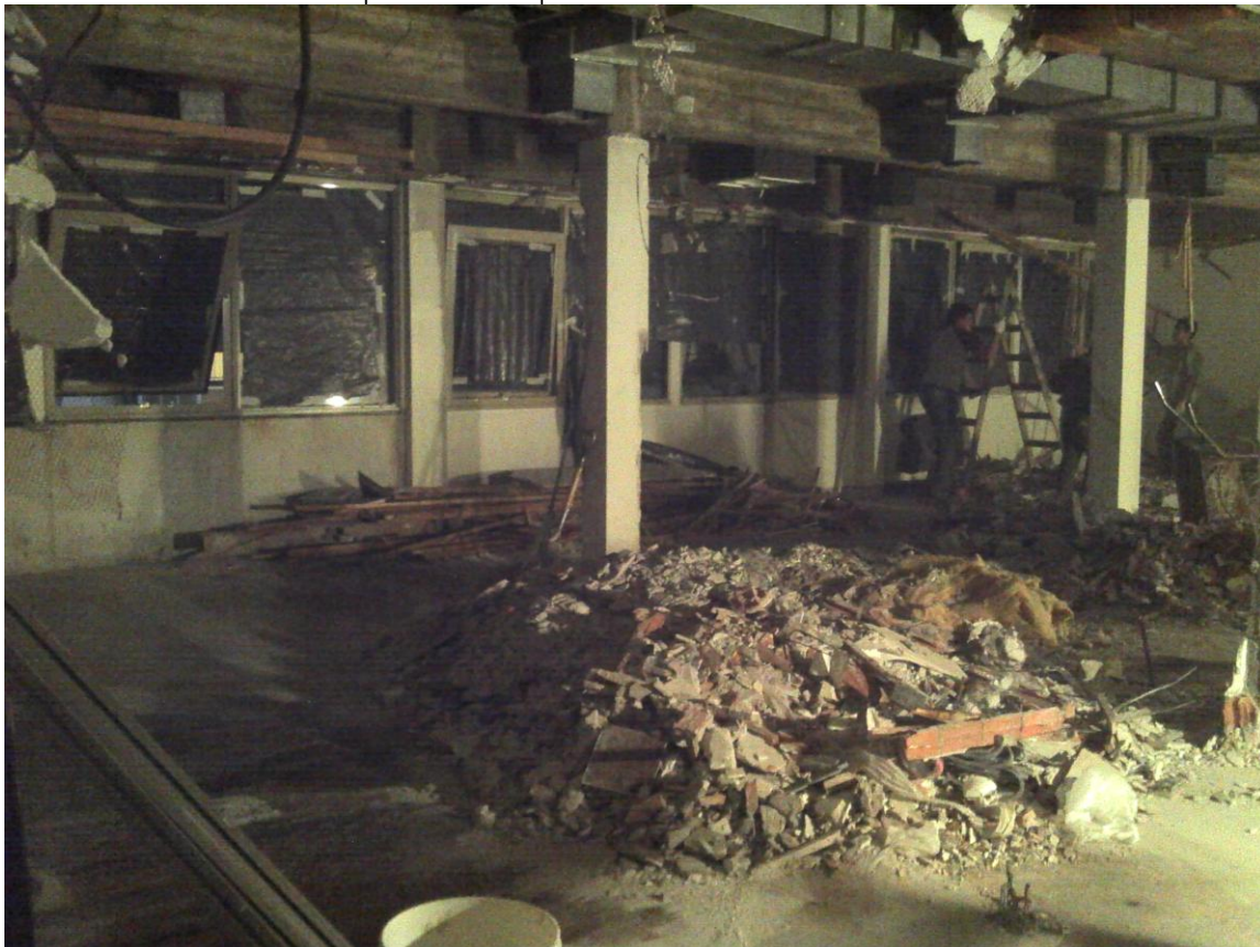
Acumulando escombros para los volquetes
