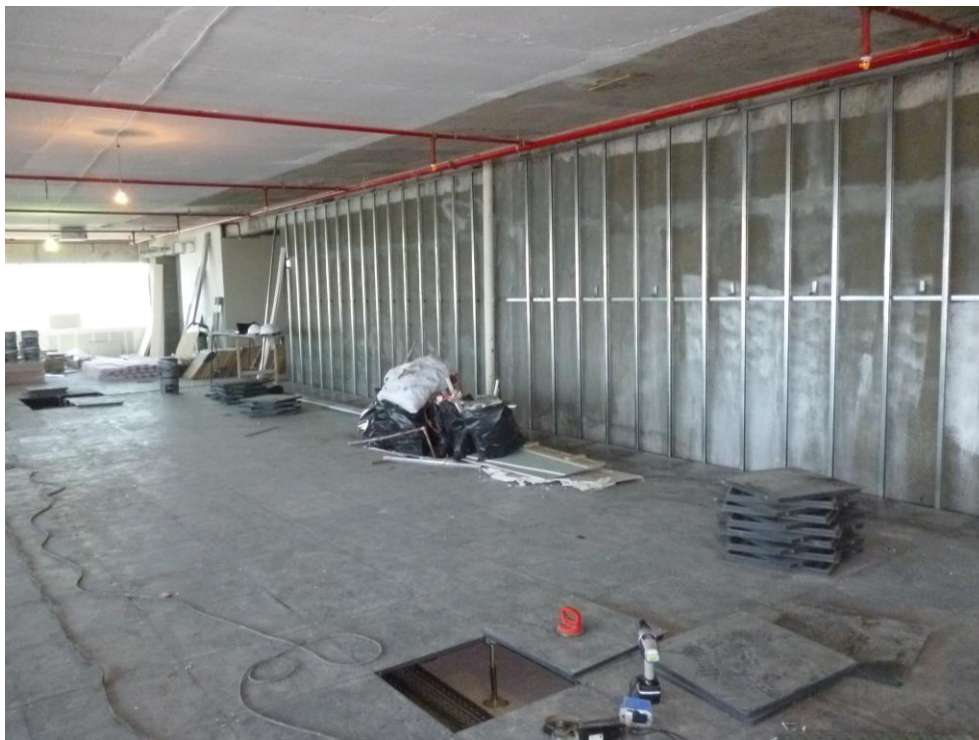
Sector ETAPA 3: - yeso: estructura de pared - pintura: pintado losa hormigón blanco
