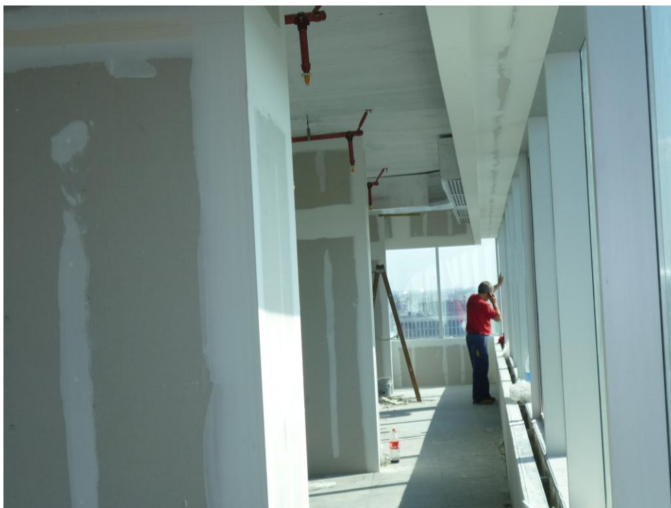
Sector ETAPA 1-2: - yeso: cajón cortinero, revestimiento columnas. - aire acondicionado: rejillas
