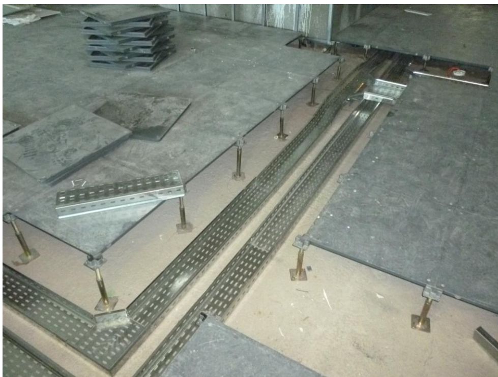
Sector ETAPA 3: - eléctrica: canalizaciones bajo piso técnico
