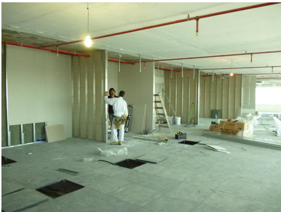
Sector ETAPA 1-2: - yeso: estructura y emplacado ambientes - pintura: pintado losa hormigón blanco
