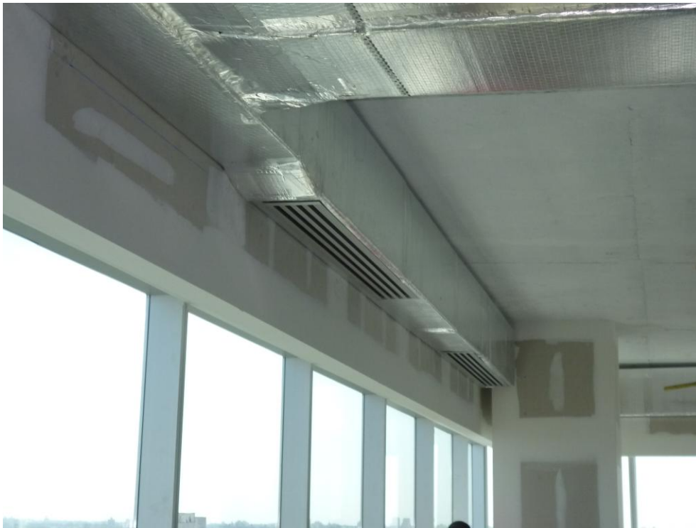
Sector ETAPA 1: - yeso: cajón cortinero, revestimiento columnas. - aire acondicionado: rejillas
