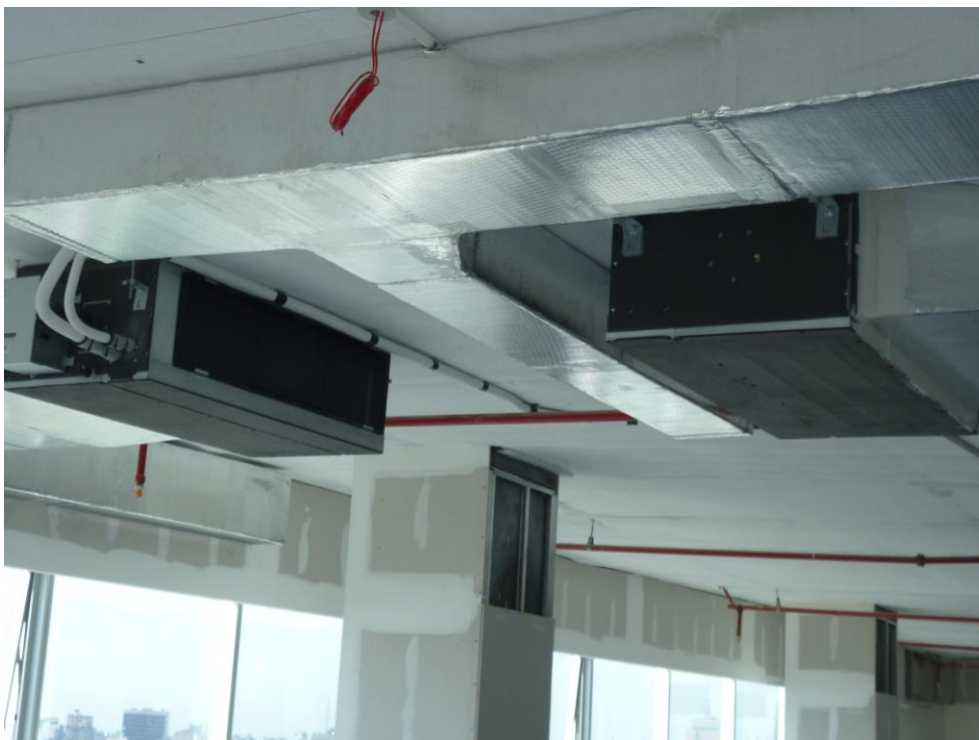
Sector ETAPA 1: - yeso: cajón cortinero, revestimiento columnas. - aire acondicionado: equipos instalados
