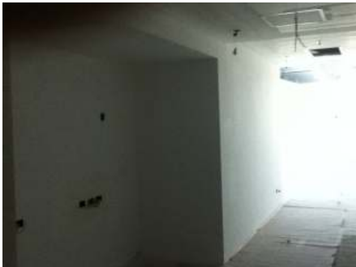
Fotos 1 y 2 - Acceso: Pasillo con cielorraso masillado y cartón cubriendo la alfombra. Paredes con una mano de pintura.
