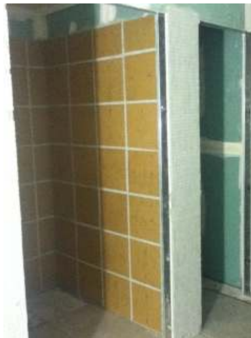
Fotos 20 y 21 – Baño hombre, etapa 2: Tabiques y cielorraso terminados, revestimientos en piso y paredes en proceso.
