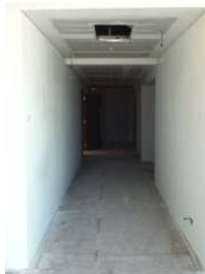
Fotos 1 y 2 - Acceso: Pasillo con cielorraso masillado y cartón cubriendo la alfombra. Paredes con una mano de pintura.
