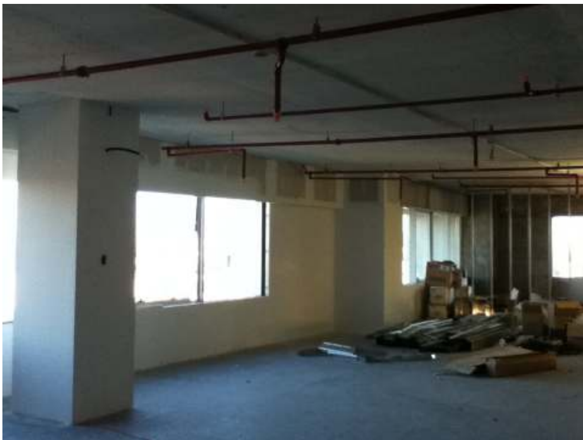
Foto 18 Sector puestos etapa 2: Tabiques con enchapado de columna y cortinero ejecutados. Instalación de sprinklers y detección de humo terminadas.
