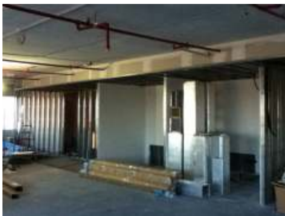
Fotos 16 y 17 Salas de reunión y Phonebooths: Estructura de cielorraso realizada y una cara de tabiques emplacada.
