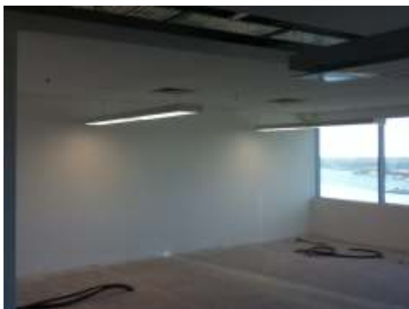
Fotos 4 y 5 - Puestos: Luminarias encendidas, cartón cubriendo alfombra y cableado listo para recibir los puestos
