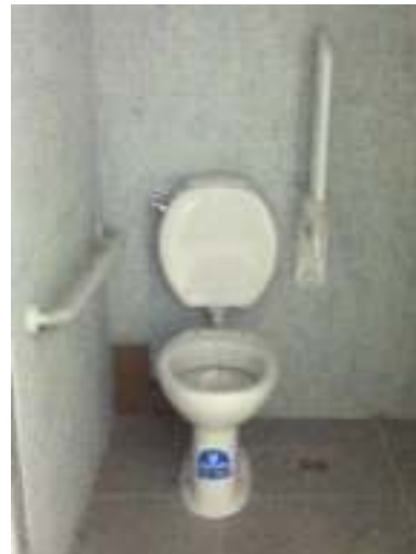
Fotos 8, 9 y 10 – Baño damas: Mesada con grifería colocada, revestimientos en paredes, tabique preparado para recibir espejo e inodoro de discapacitados instalado.
