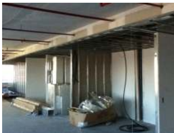
Fotos 16 y 17 Salas de reunión y Phonebooths: Estructura de cielorraso realizada y una cara de tabiques emplacada.
