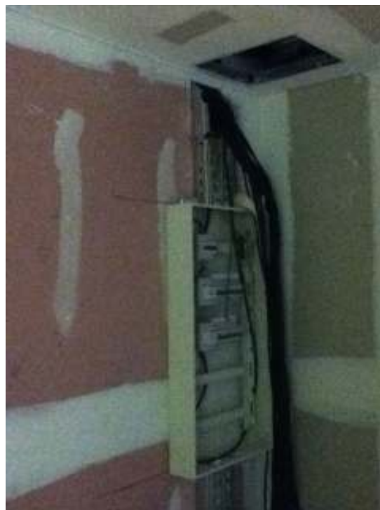
Fotos 6 y 7: Se aprecian paredes y cielorraso masillado con instalación preparada para recibir luminarias. Revestimiento en piso colocado y tablero con protecciones preparado para conectar.
