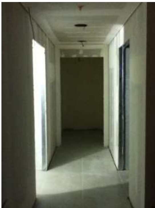
Fotos 6 y 7: Se aprecian paredes y cielorraso masillado con instalación preparada para recibir luminarias. Revestimiento en piso colocado y tablero con protecciones preparado para conectar.
