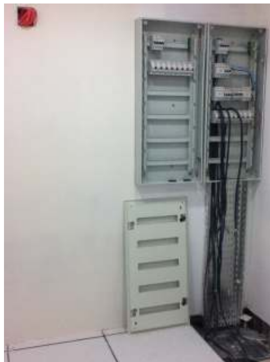
Fotos 14 y 15 – Sala UPS: Piso técnico terminado, puerta F-60 y aire acondicionado con paredes lijadas. Tablero con protecciones y llegada de cables listos para conectar.
