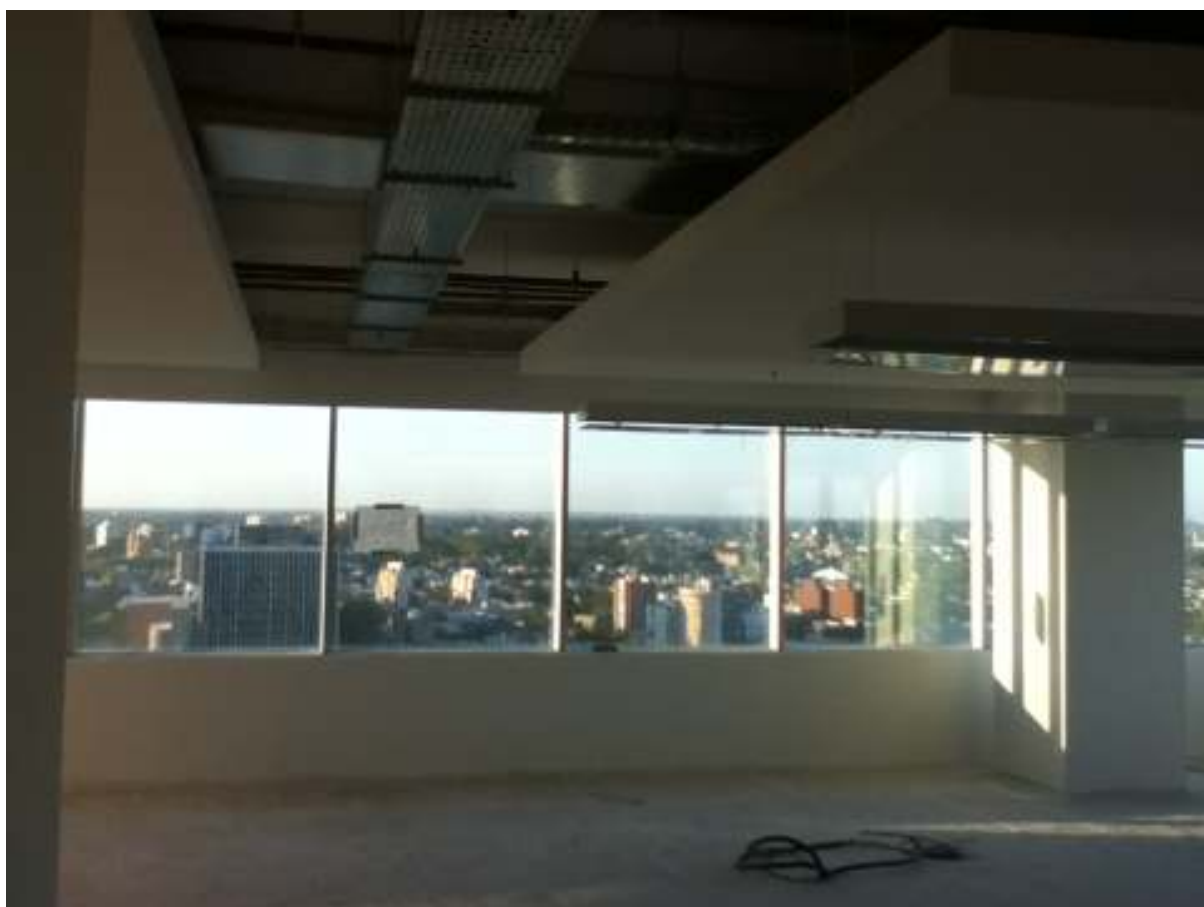
Foto 3 - Puestos: Cielorraso y paredes terminados con luminarias sobre puestos de trabajo instaladas e instalaciones listas para recibir el mobiliario.
