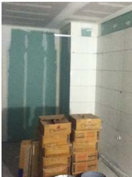
Fotos 20 y 21 – Baño hombre, etapa 2: Tabiques y cielorraso terminados, revestimientos en piso y paredes en proceso.
