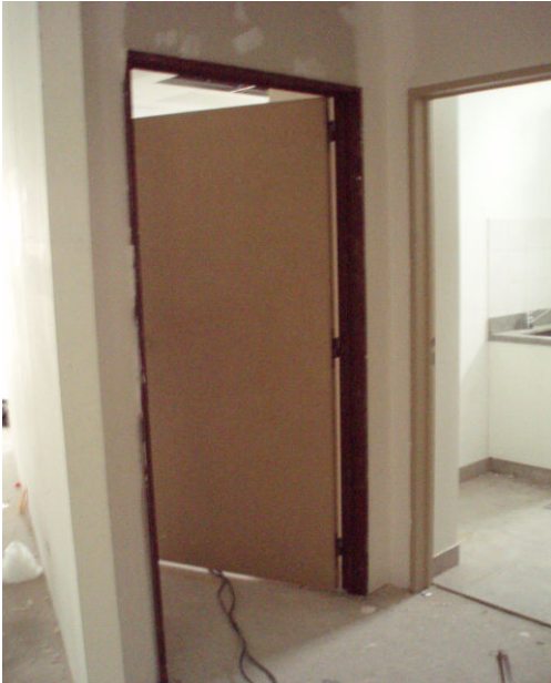
COLOCACION PUERTA NUEVA SALA COPY FAX PISO 7.
