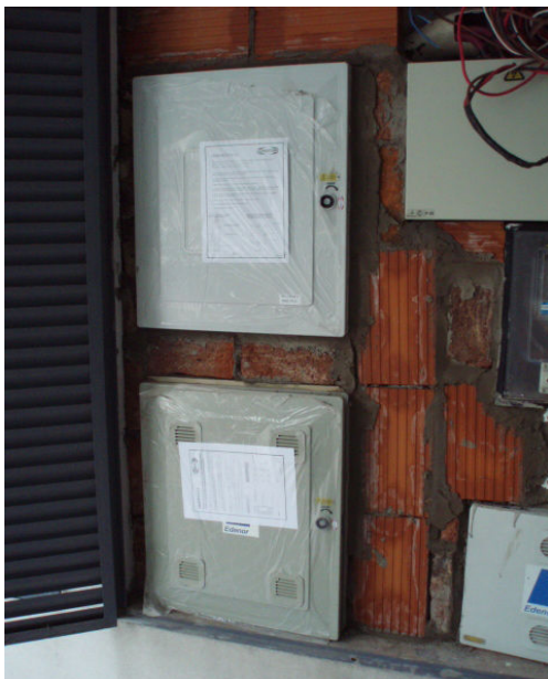
OBRA CIVIL MEDIDOR COLOCACION DE GABINETES.
