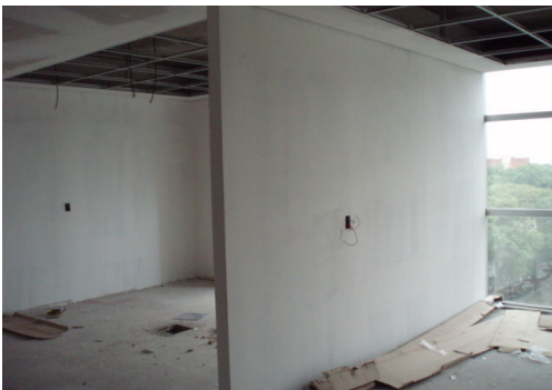
ENDUIDO COMPLETO TABIQUES Y PAREDES PISO 7.
