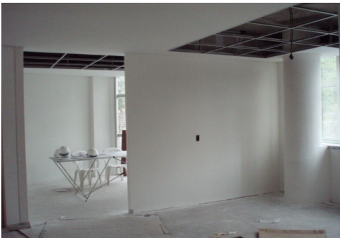
ENDUIDO, LIJADO Y PINTURA CIELORRASOS Y PAREDES PISO 3.
