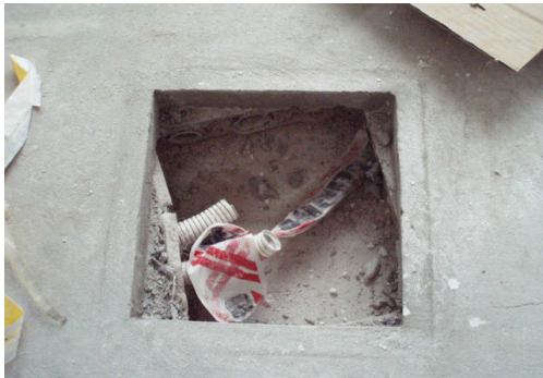
RECTIFICADO CAJAS DE PISO. PISOS 3-7-8-9-10.
