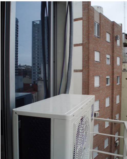
ALIMENTACION ELECTRICA UNIDADES CONDENSADORAS.
