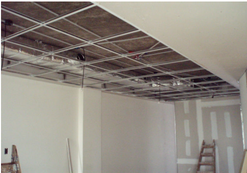
COMIENZO ARMADO ESTRUCTURA CIELORRASO DESMONTABLE PISO 8.
