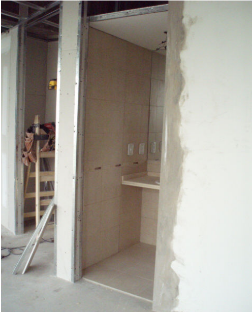
COLOCACION REVESTIMIENTO BAÑO DESPACHO EMBAJADOR PISO 9.
