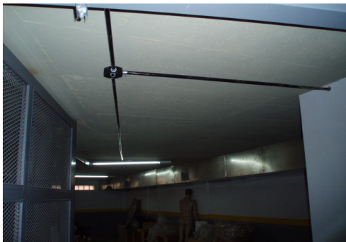
COLOCACION CAÑERIAS VACIAS DETECCION DE INCENDIO COCHERAS.
