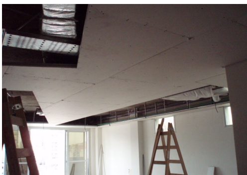
EMPLACADO AJUSTES CIELORRASO PISO 9.
