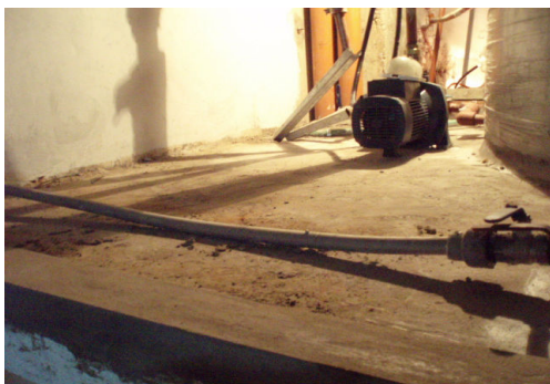
TRABAJOS ALBAÑILERIA DESBORDE TANQUES DE RESERVA Y BOMBEO PB. REALIZACION DE CARPETA CON PENDIENTE A NUEVO DESAGÜE.
