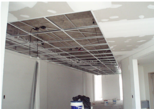
ARMADO COMPLETO ESTRUCTURA CIELORRASO DESMONTABLE PISO 7.
