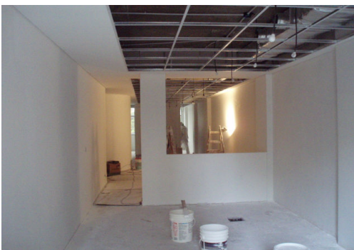
ARMADO ESTRUCTURA CIELORRASO DESMONTABLE PISO 3.
