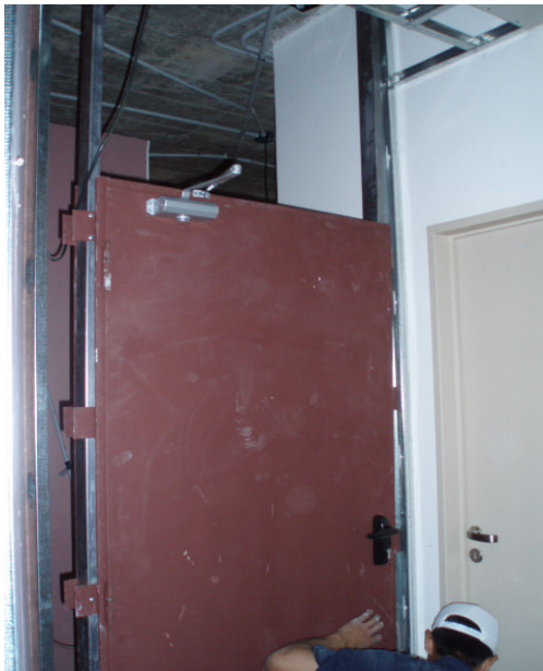
PROVISION DE REFUERZOS METALICOS Y COLOCACION PUERTA F60 DATA CENTER.
