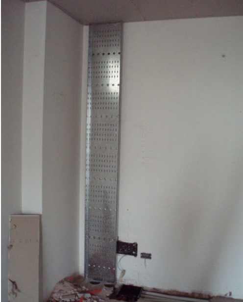
COLOCACION BANDEJAS PB A PISO 9.
