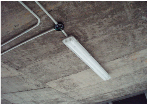
INSTALACION DE SISTEMA DETECCION INCENDIO, ILUMINACION Y COLOCACION DE ARTEFACTOS PISO 4.
