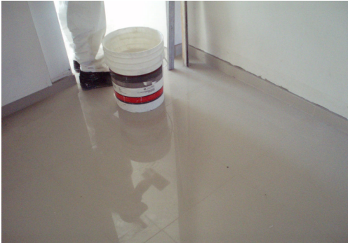
COLOCACION ZOCALOS Y EMPASTINADO PORCELANATO PISO 3
