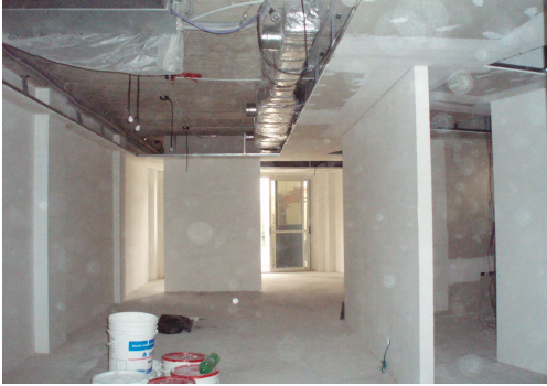
INICIO TRABAJOS DE PINTURA
