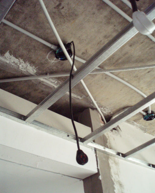
COLOCACION CHICOTES ARTEFACTOS ILUMINACION
