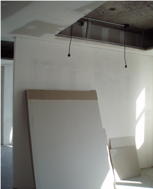
ENDUIDO COMPLETO TABIQUES Y PAREDES PISO 3
