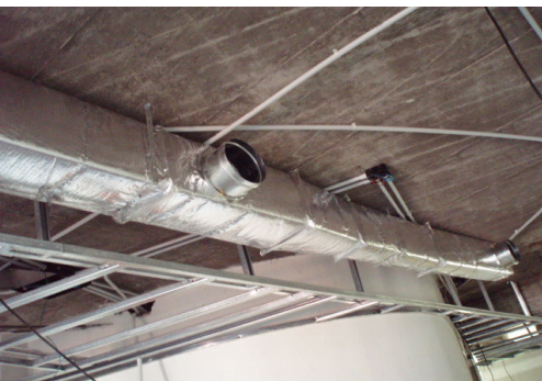
INICIO COLGADO DE CONDUCTOS AIRE ACONDICIONADO PISO 9
