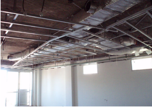
ARMADO ESTRUCTURA DE AJUSTES DE CIELORRASO PISO 9
