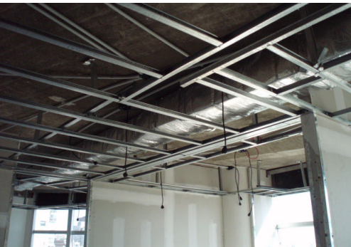
FINALIZACION COLGADO DE CONDUCTOS AIRE ACONDICIONADO PISO 8
