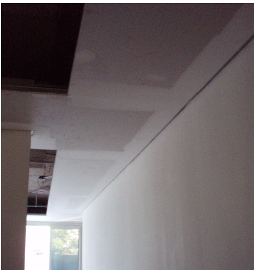
EMPLACADO Y MASILLADO AJUSTES CIELORRASO PISO 03
