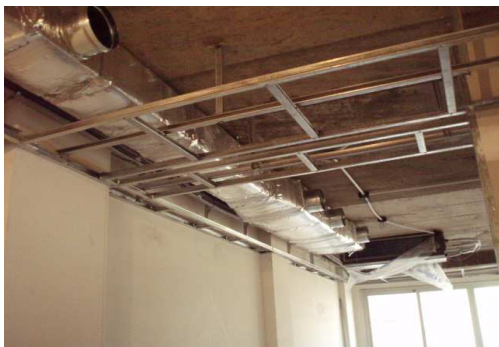
TENDIDO DE CONDUCTOS DE AIRE ACONDICIONADO PISOS 03-07
