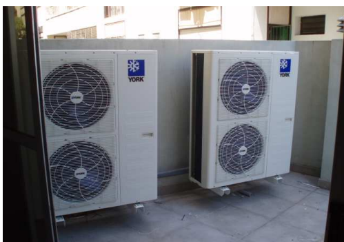
COLGADO UNIDADES CONDENSADORAS PISO 03
