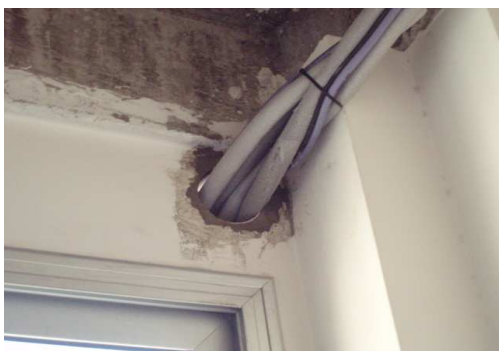
APERTURA DE PASES PARA CONEXIONES DE UNIDADES CONDENSADORAS EN PISOS 3-7-8-9-10
