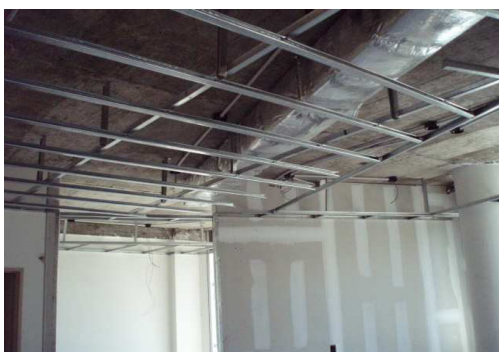
ESTRUCTURA DE AJUSTES CIELORRASO PISOS 03-07 COMPLETA
