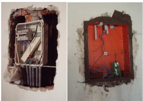
RETIRO DE TABLEROS EXISTENTES Y COLOCACION Y AMURADO NUEVOS TABLEROS PISOS 09- 10.
