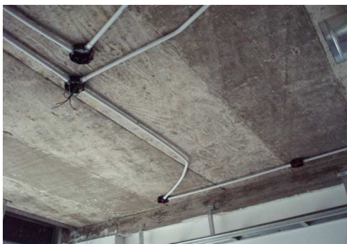
CABLEADO CIRCUITO DE ILUMINACION PISOS 03 - 07
