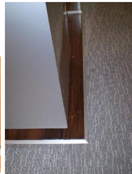
Cubrejuntas metálicas para unión de diferentes tipos de pavimentos
