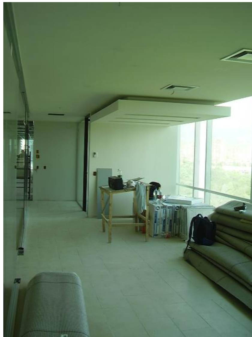
Estructura en volcometal placa yeso cartón 10mm
