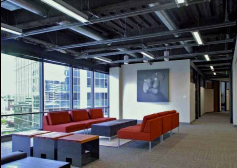
Losa a la vista
