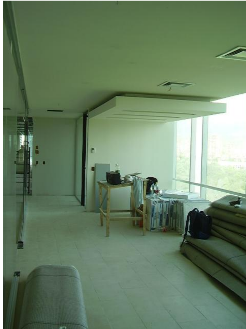
Estructura en Volcometal placa yeso cartón 10mm
